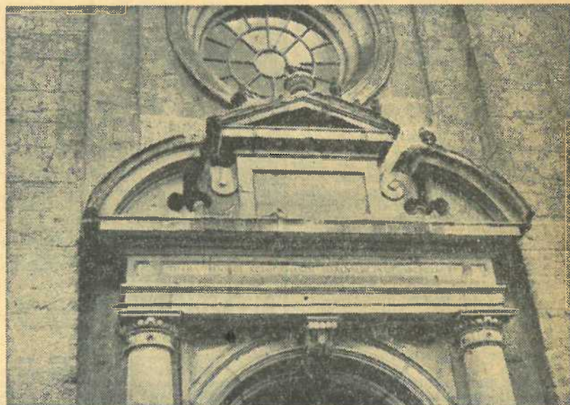
Auf dem Querbalken dieses Schloßportals ist der Name des Schloßbauers, Heinrich Schickhardts, verewigt. Bild: Wiedermann
