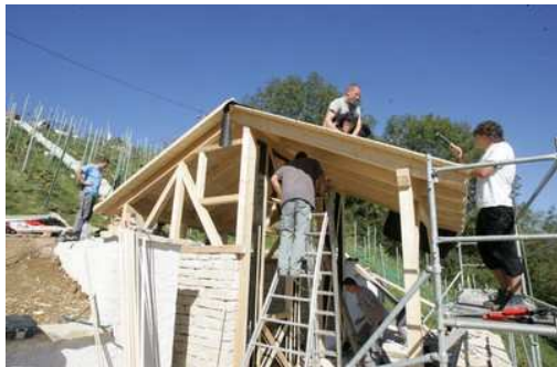
Un cabanon de vignes vient d'être installé. Photo J.-L. GILLMÉ
